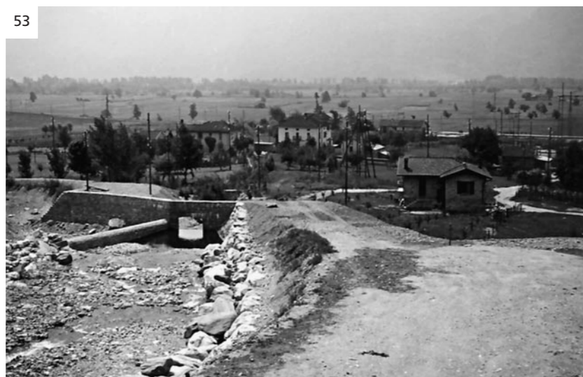
53 Veduta dallo sbocco sul conoide del Riale Pesta verso Sud; si osserva, a sinistra, la camera di raccolta costruita qualche anno prima e la sistemazione dell'argine destro dopo l'alluvione del 1948.
