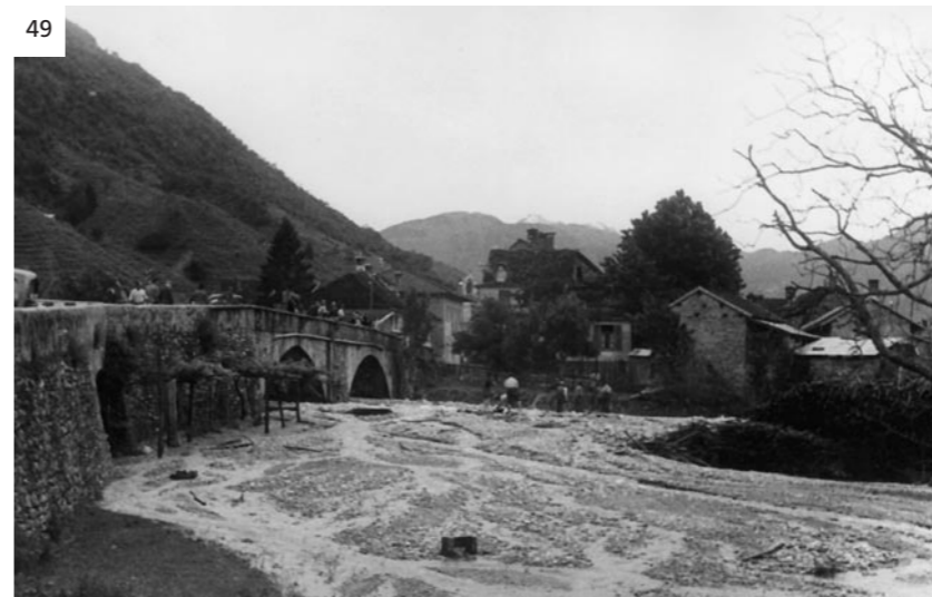
49 Il Riale Riarena a valle del ponte della strada cantonale il 19 giugno 1948.
