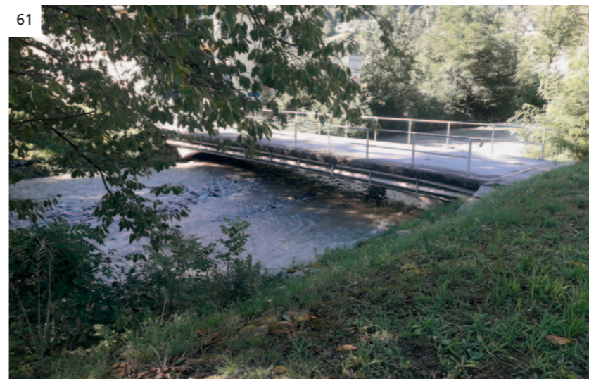
61 Ponte sul Riarena in zona Boscioredo; la grande quantità di materiale alluvionale depositata in alveo ha limitato in modo importante la sezione di deflusso sotto il ponte, 30 agosto 2020.
