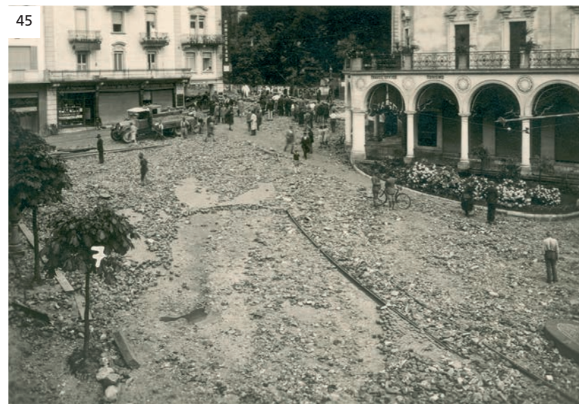
45 Il 23 luglio 1930 il torrente Ramogna, che segna il confine tra Locarno e Muralto, è uscito dal suo letto causando ingenti danni.
