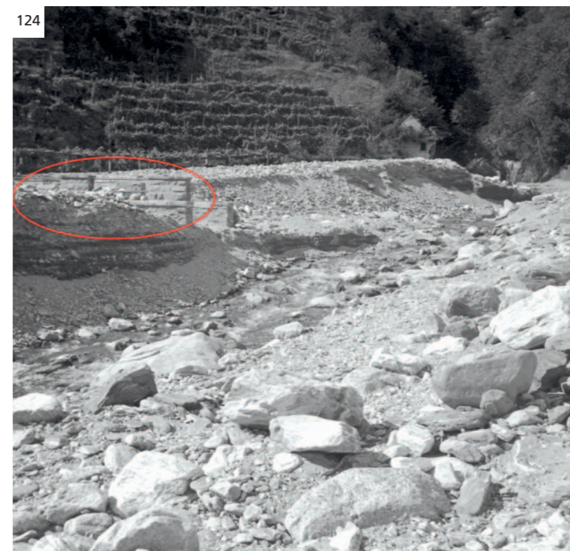
124 Alluvione del 16 giugno 1948: il ponte per Agarone-Medoscio è completamente sommerso dai detriti (se ne riconosce a malapena il parapetto cerchiato in rosso): il riale si è scavato un nuovo letto sulla sponda sinistra, verso l'abitato di Cugnasco.
